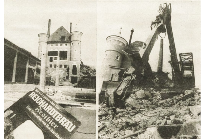
Der Abriss des Reichardtbräus in den späten 80er Jahren.
